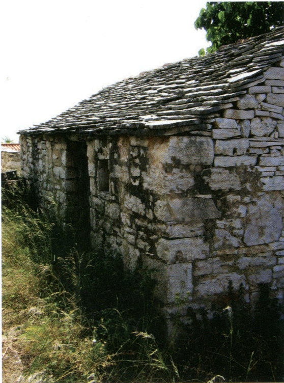
Pokrov kamenom pločom.
