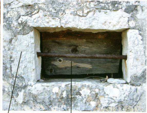
doprozornici iz priklesanih kameni blokova
