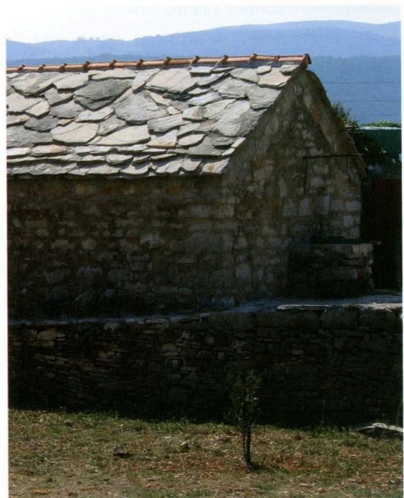
Novi krov na kamenoj kućici izveden je od betona na koji su nalijepljene loše složene kamene ploče.
