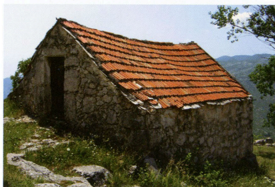
Raščane, Belajići. Gospodarska kućica položena okomito na slojnice sa stajom u prizemlju i sjenikom u potkrovlju.
