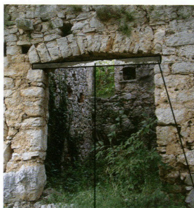
kameni luk kod širokih otvora rasterećuje drvenu gredu
