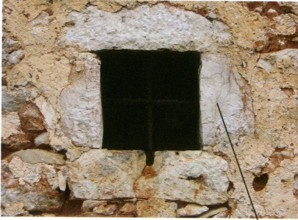
doprozornici iz priklesanih kameni blokova
