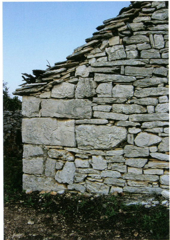
Ugao i struktura zida suhozidne kućice.
