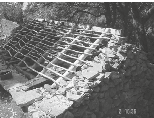
Izgled poletvanoga krova
