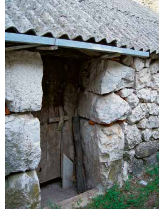
Ulaz. Iznimno veliki kamenovi nisu baš najbolje ugrađeni pa su u novije doba učvršćeni purpjenom. O problematici pokrova nešto kasnije
