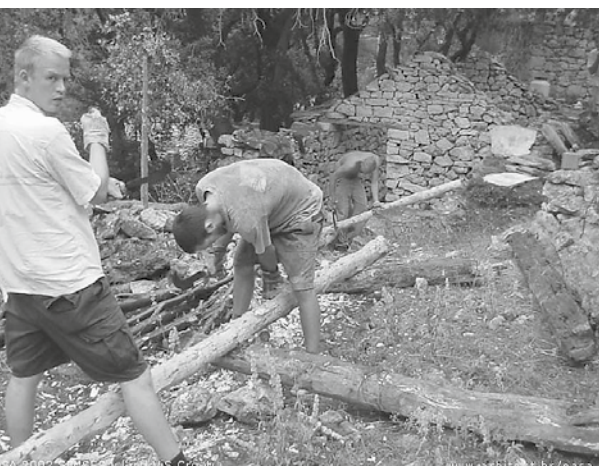
Obrada drvene građe: vide se borove grede i granje joprine
