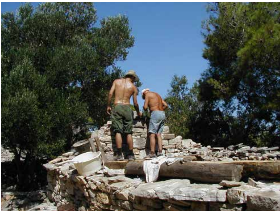
Zidanje lastavice. Buduća vezna greda krova poslužila je kao skela
