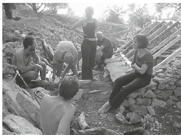
Izrada konstrukcije krova (jedan radi, drugi se odmaraju)
