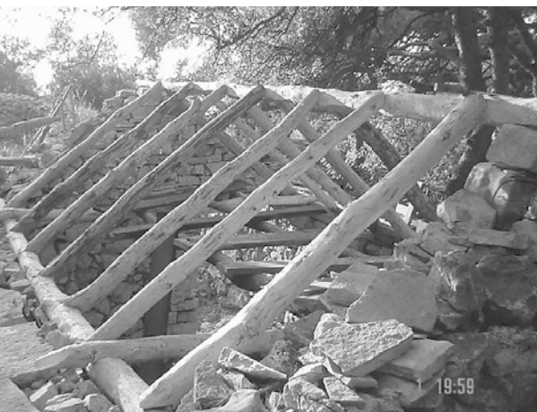
Gotova konstrukcija krova; vidi se improvizirana skela između greda
