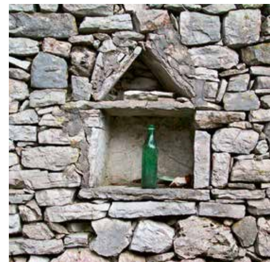
Ponar – niša u zidu s rasterećenjem od kosih ploča
