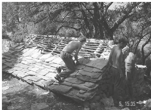
Postavljanje kamenih ploča
