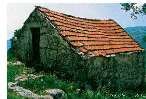
U selima srednje Dalmacije češći je običan utoreni crijep nego kupa kanalice
