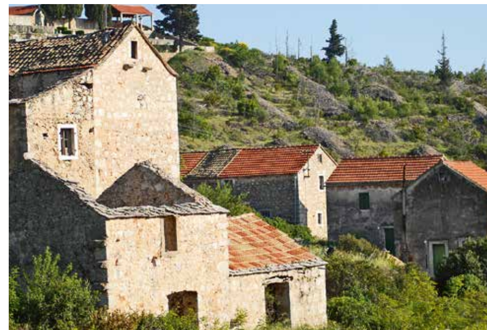
Velo Grablje na Hvaru. Na povoljnim lokacijama, jednostavni sklopovi suhozidnih kućica vremenom su izrasli u velika utvrdo zidana sela sa kućama katnicama
