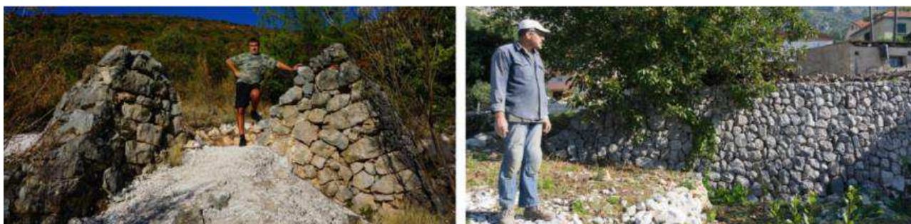
Fotografija: Suhozidni majstori Ivo Antunović i Pero Kukuljica i njihov rad (ostaci vapnenice, pregradni zid)
