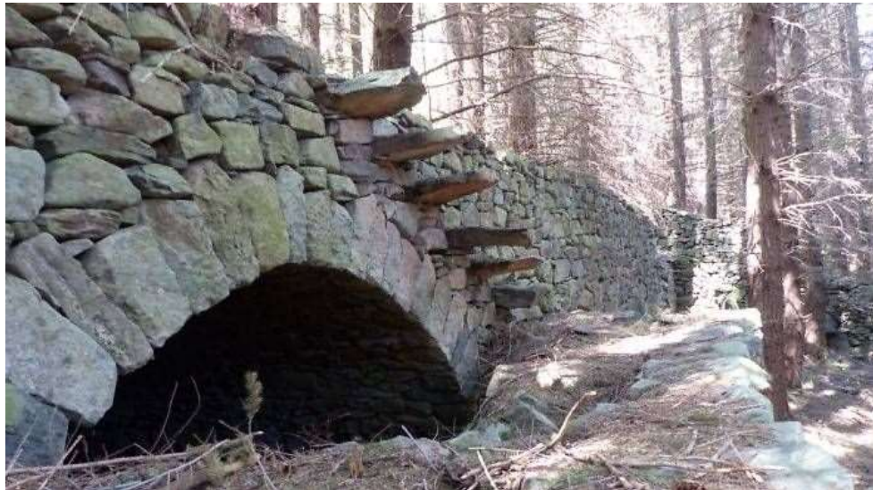
Fig. 3 Voûte qui abrite une écluse.
