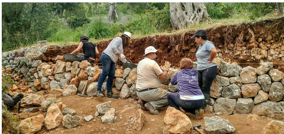
Fig. 8. Cours d'initiation à la construction de murs de soutènement organisé par le Consell de Mallorca (2018)
