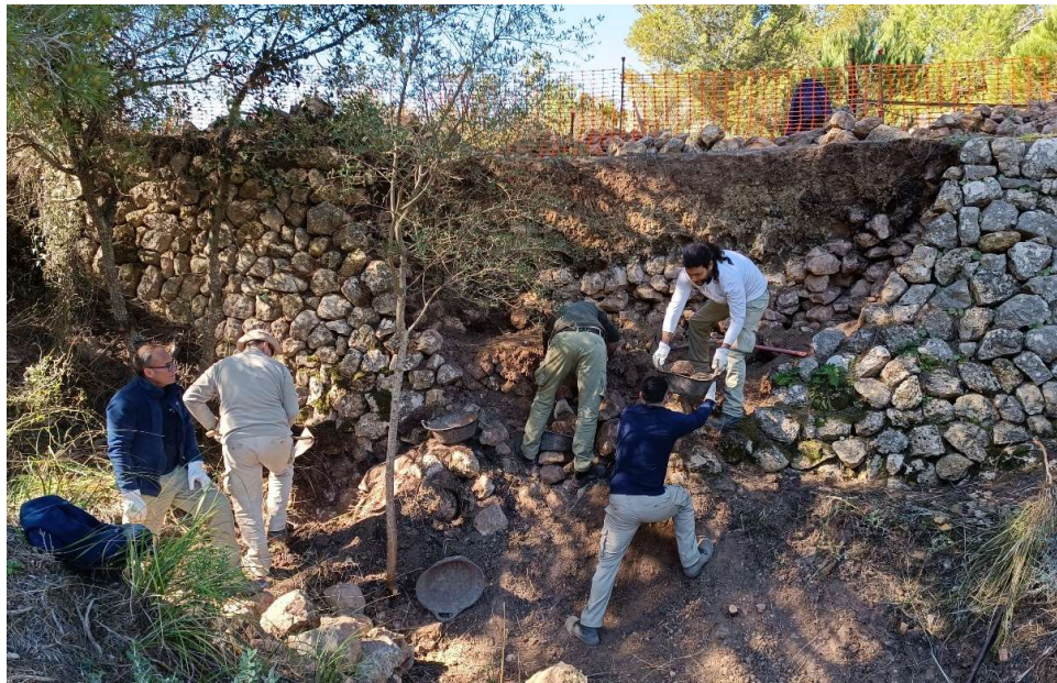
Fig. 6. Restauration d'un mur de soutènement du chemin Camí des Correu (février 2022), qui fait partie de la Route de la Pierre Sèche.
