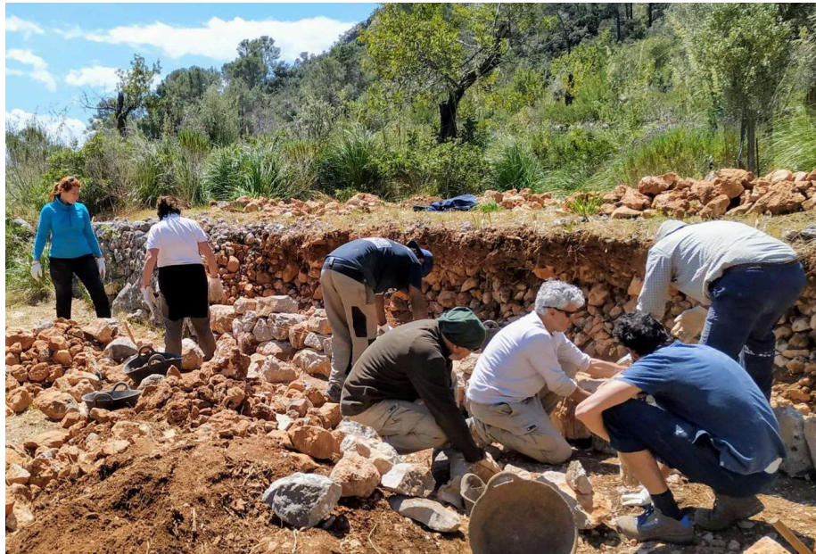
Fig. 1. Cours d'initiation à la construction de murs de soutènement organisé par le Consell de Mallorca (mai 2019)
