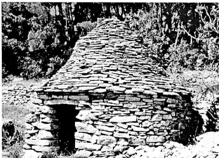
Sl. 9 (Kameno sklonište, Potoračje, Korčula) i sl. 10 (Kameno sklonište u Francuskoj: Gordes, Provansa) (Izvor: Juvanec, B. 2005: 87) »Zvonasti« oblik krova u Veloj Luci je sličan obliku krova kamenog skloništa u Francuskoj. Očit je prijenos znanja o gradnji kamenih skloništa.
