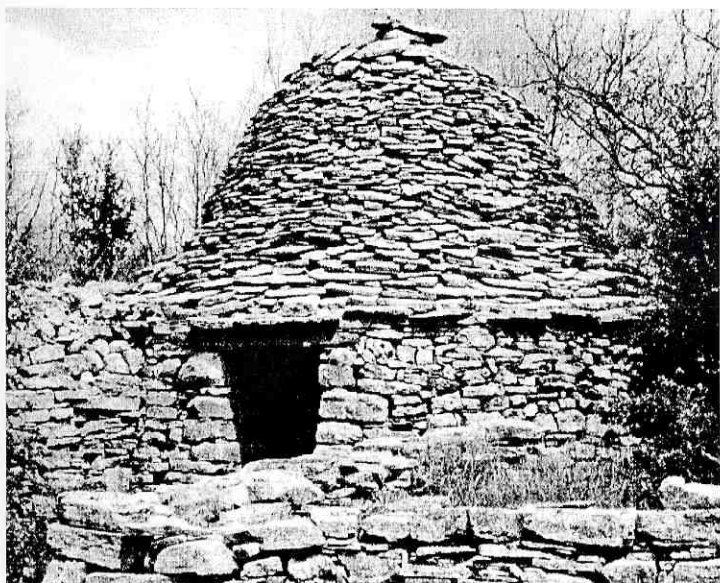
Sl. 9 (Kameno sklonište, Potoračje, Korčula) i sl. 10 (Kameno sklonište u Francuskoj: Gordes, Provansa) (Izvor: Juvanec, B. 2005: 87) »Zvonasti« oblik krova u Veloj Luci je sličan obliku krova kamenog skloništa u Francuskoj. Očit je prijenos znanja o gradnji kamenih skloništa.
