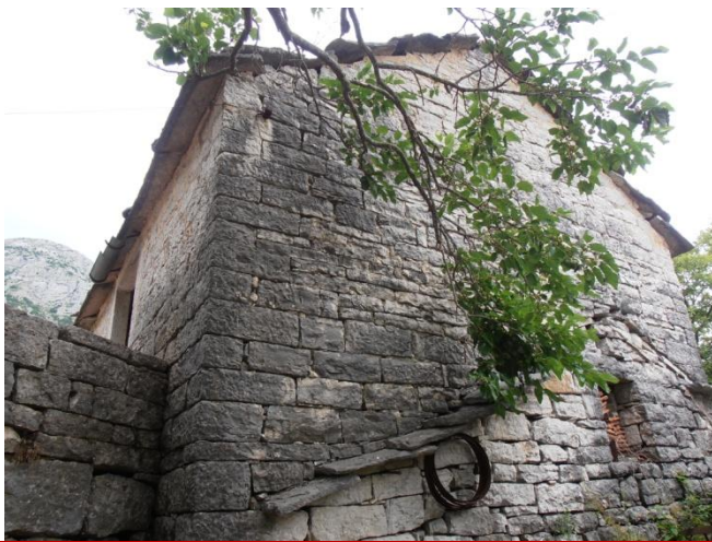
Preciznost obrade kamenih blokova
